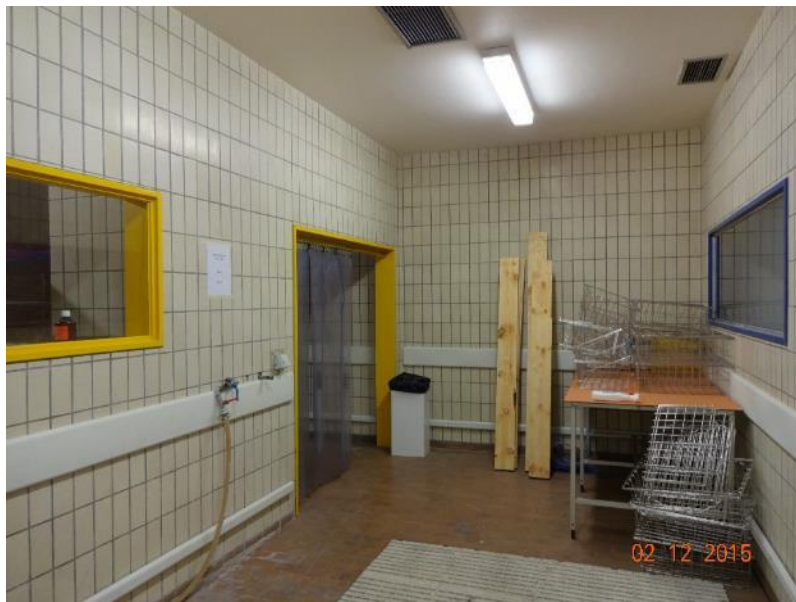
Zone de lavage
