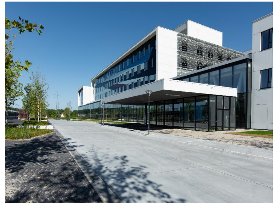
L'hôpital général Sint-Maarten à Malines, © VK Architects & Engineers
